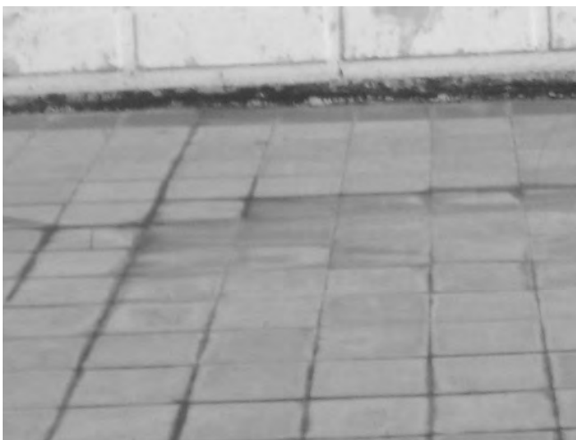
Foto 1. A) Aspecto del suelo de la torre en la ETITC.
